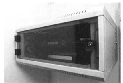
Die Inneneinheit der Basisstation: Satellitenmodem und Proxy Server integriert in einem kleinen 19-Zoll Wandgehäuse
