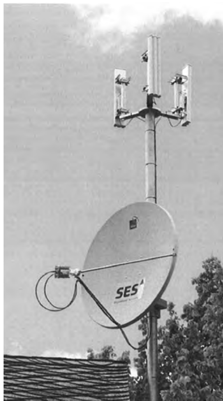
Satellitenantenne und Funkantennenanordnung
