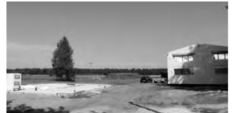
Im Sprengersfelder Weg entstehen zwei Häuser
