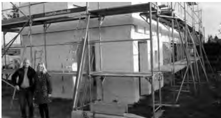
Baustelle Multiples Haus
