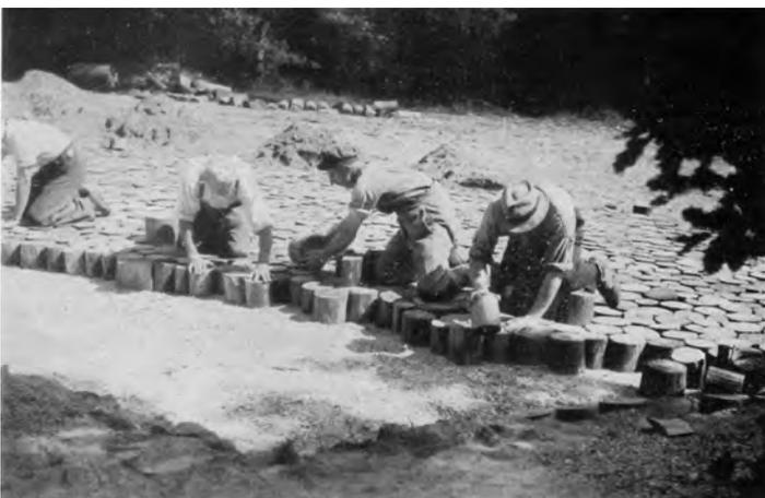
Um 1935 wurde von Hintersee über Mützelburg in Richtung Ziegenort eine Holzstraße gebaut. Dafür wurde Kiefernholz aus den heimischen Wäldern genutzt, welches geschält und impregniert wurde. Die ausgebaute Holzstraße hatte eine Länge von 10,5 km und eine Fahrbahnbreite von fünf Metern.
