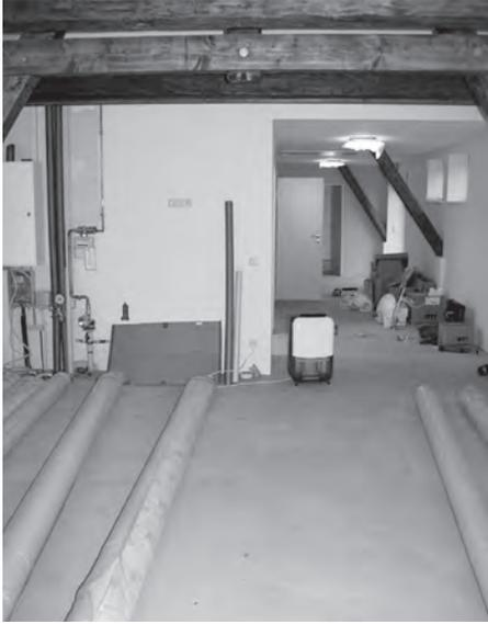
Nach einem längeren Baustopp aufgrund zu hoher Feuchtigkeit im Unterbeton wurde kürzlich damit begonnen, den Fußbodenbelag zu verlegen.
