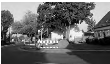
2014 - die größte Baustelle in Meiersberg
