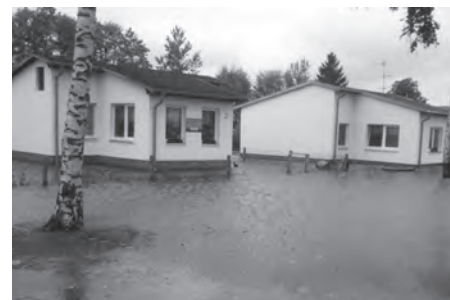
Die Bungalows standen unter Wasser.
