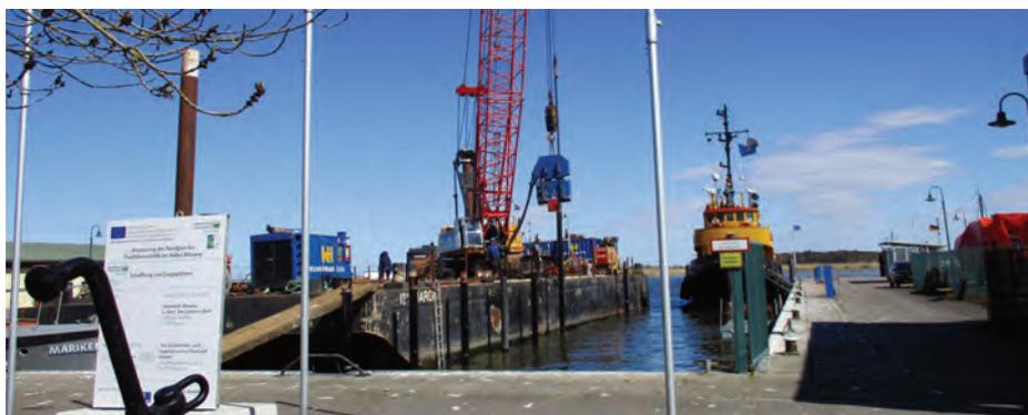
Gegenwärtig ist schwere Technik dabei, an der Nordseite des Hafens die Spundwand 20 Meter zu verlängern. Diese soll Möglichkeiten bieten, dass Traditionsschiffe wie z.B. die Pommernkogge „UCRA“ in Altwarp anlegen können. An der Südseite werden 16 neue Liegeplätze für Sportboote gebaut. Die Arbeiten sollen planmäßig noch im Mai 2020 abgeschlossen werden.
