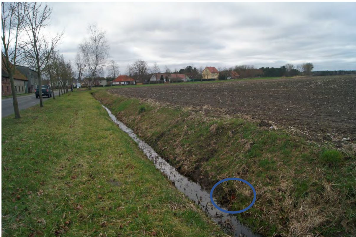
Abbildung 7: Einleitung der Dränage in den Graben 0:07.03.04 (© LAIV – MV 2020)
